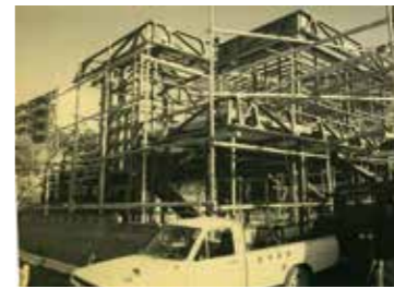
さわらび園建築始まる(昭和47年)
