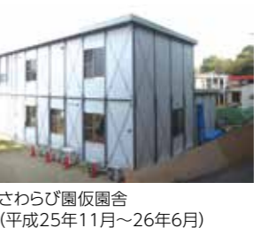
さわらび園仮園舎(平成25年11月~26年6月)
