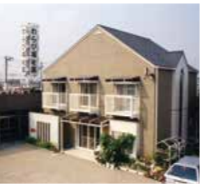
わらび第2ホーム(平成4年)
