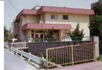
さわらび園(道路脇に水路がある)
